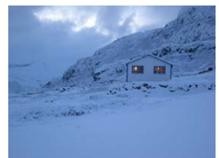
en cours de rénovation...
