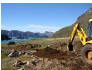
construction d'un chemin
